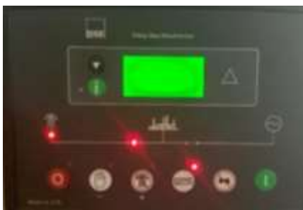
Gambar 2. Foto Modul Deep Sea Electronics 8610 Pada PT. Cahaya Fajar Kaltim.
