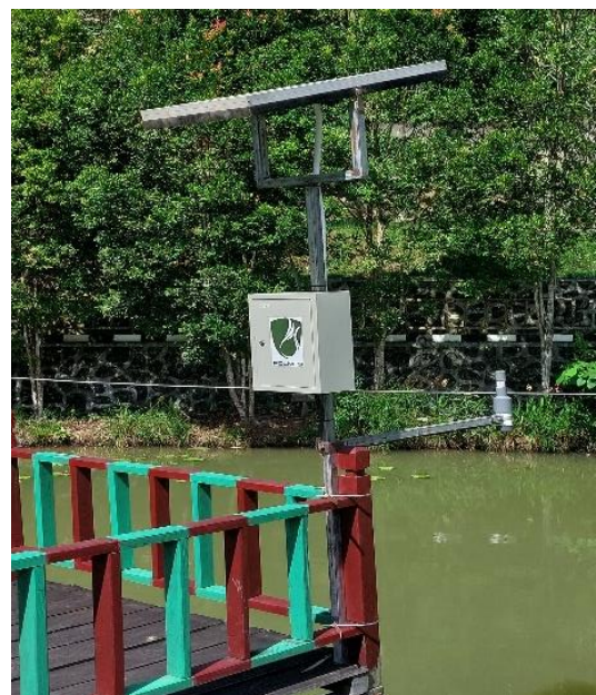
Gambar 29. Pemasangan alat monitoring di danau Politeknik Negeri Samarinda
