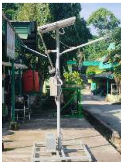
Gambar 28. Miniatur PJUTS dengan sistem solar tracker tampak samping kanan.
