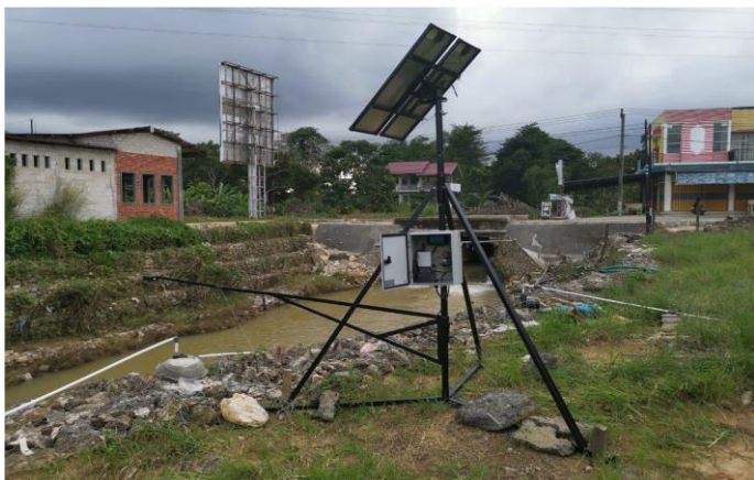
Gambar 9. Hasil pemasangan AWLR di lokasi Km5
