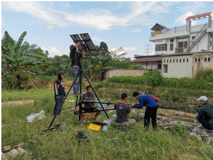
Gambar 8. Kegiatan pemasangan/instalasi AWLR di lokasi Km5
