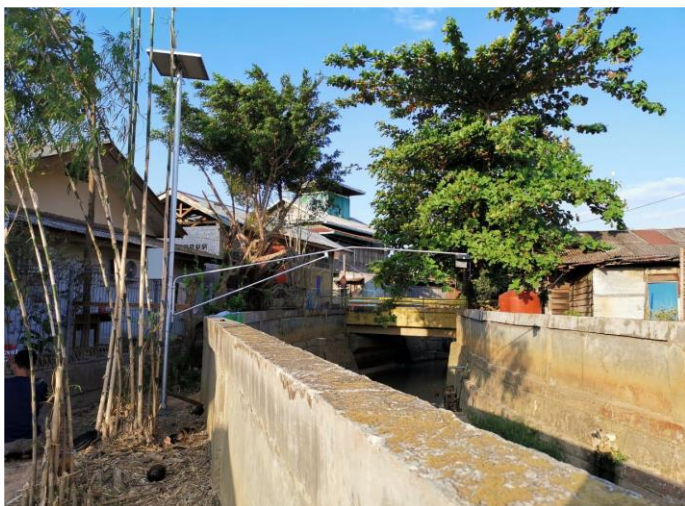
Gambar 10. Hasil pemasangan AWLR di IN BIS.
